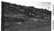
Fig. 4.—Contacto Jurásico-Cretácico, en Mazatepec, Pue. Obsérvase el Berriasiano (Formación Tamaulipas Inferior), plegado localmente; 100 m. antes de llegar al pueblo de Mazatepec, Pue.
