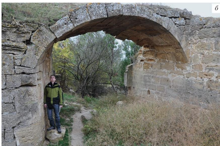
**Рис. 11.** Деформации арочных конструкций в постройках крепости Ени-Кале
