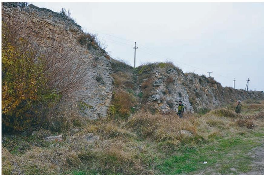
**Рис. 9.** Разрыв в юго-восточной стене крепости Ени-Кале вследствие ее отседания к морю и разворота северо-восточной части стены длиной 50 м против часовой стрелки на  $15^\circ$
