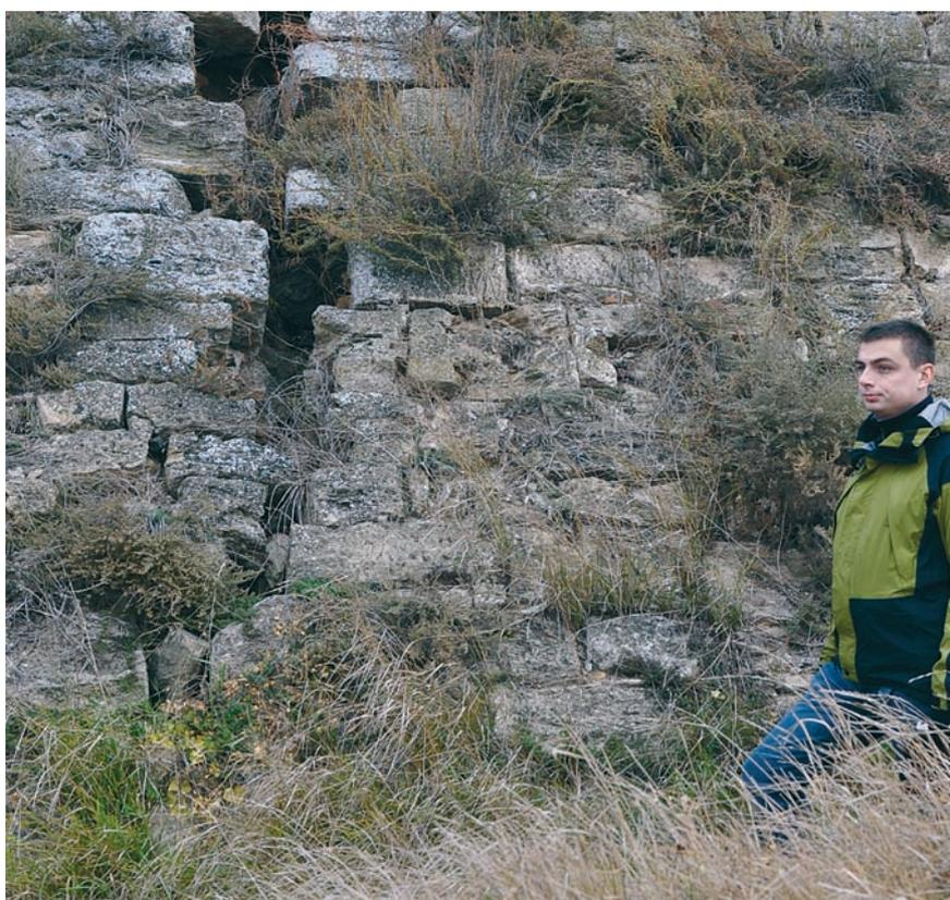
**Рис. 10.** Межблоковая субвертикальная трещина на всю высоту юго-восточной стены крепости Ени-Кале
