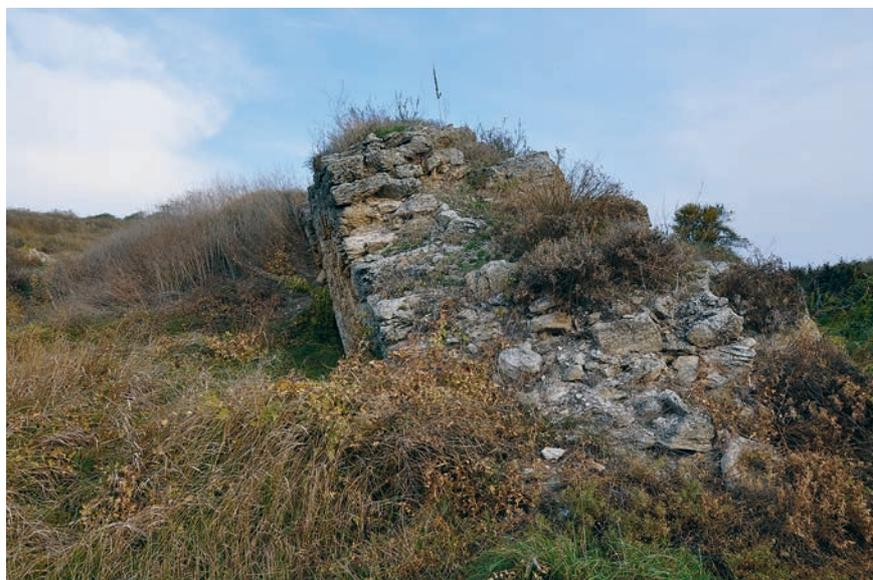
**Рис. 13.** Наклон восточной стены ( $Az = 120^\circ$ ) крепости Ени-Кале (внутренняя часть) к юго-западу под углом  $75^\circ$  против уклона местности
