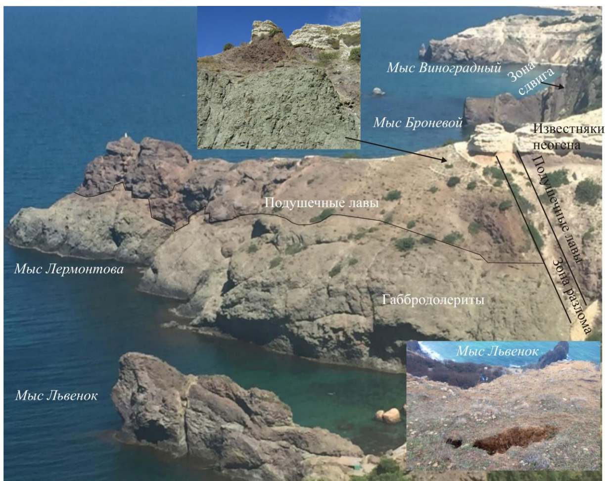
Рис. 6. Разрушение известняков неогена в зоне разрыва. На врезках: сверху – брекчированные габбродолериты основания мыса Лермонтова; внизу – трещины отрыва активного оползня неогеновых известняков в районе мыса Лъвенок
