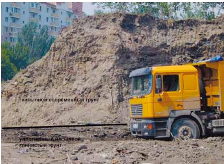
Рис. 3.3.13. Граница новейшей насыпной толщи со слоем уплотненного глинистого грунта (т.н. 16)
