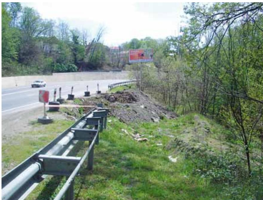
Рис. 1.2.62. Оползень, частично разрушивший полотно дороги Дагомыс – Сочи
