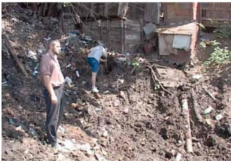
Рис. 3.3.10. Выход вод по уплотненным насыпным грунтам и дополнительное увлажнение склона местными жителями (труба в правой части снимка, т.н. 30)
