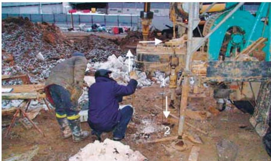
Рис. 1.2.18. Гамма-каротажное зондирование: 1 – кабель; 2 – створ скважины. Стрелками показано направление движения кабеля при опускании зонда. Фото Р.Р. Габдуллина
