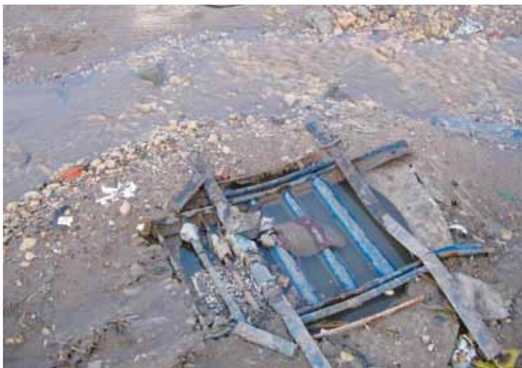
Рис. П40. Поверхностное подтопление улиц в результате замусоривания ливневых коллекторов в долине Глебучева оврага
