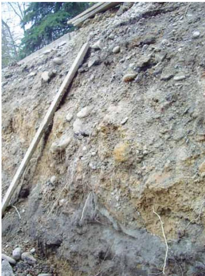
Рис. 3.2.37. Разрез строительной траншеи на Курортном проспекте рядом со стадионом Славы Метревели. В верхней части снимка – слой 1 (бровка асфальта, правее верхнего края доски). В нижней части снимка – граница слоев 4 и 5
