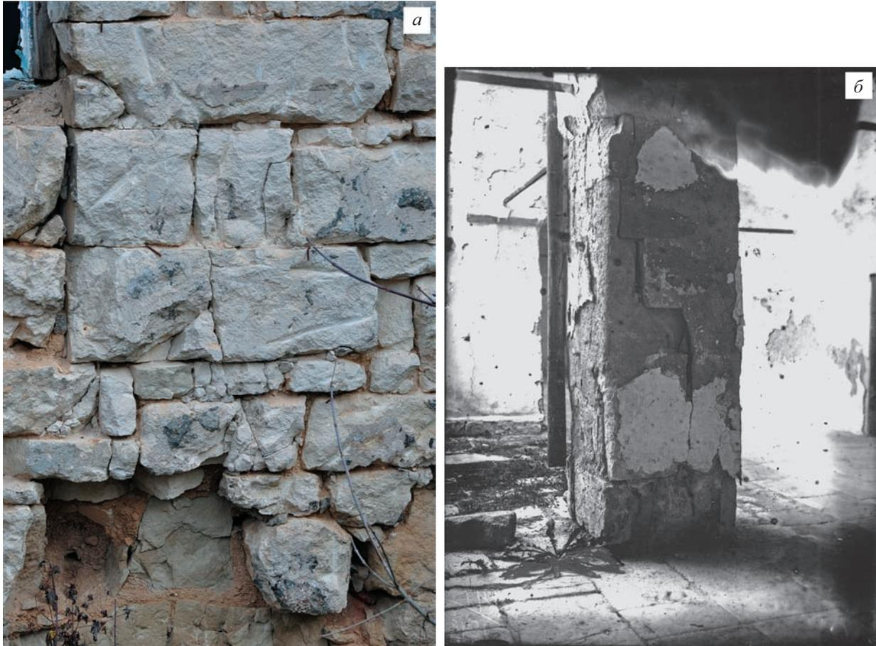
**Рис. 3.** Сквозные трещины в каменной кладке помещений в Салачике
