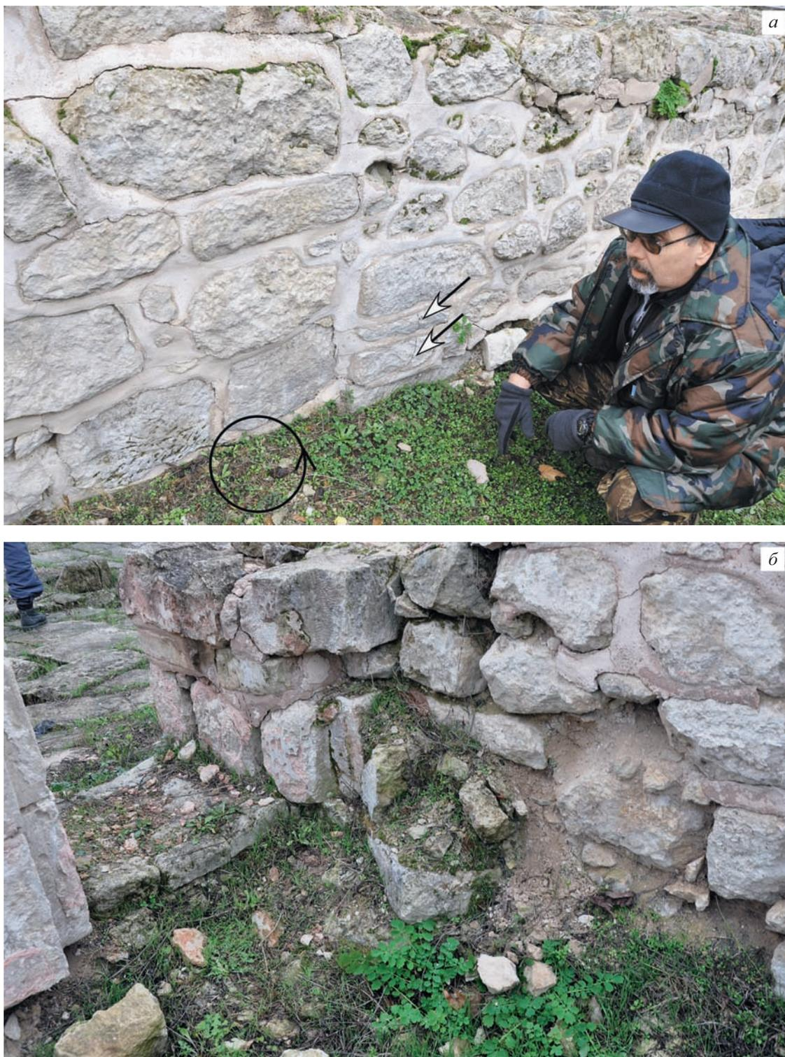
**Рис. 10.** Развороты строительных конструкций в Салачике
