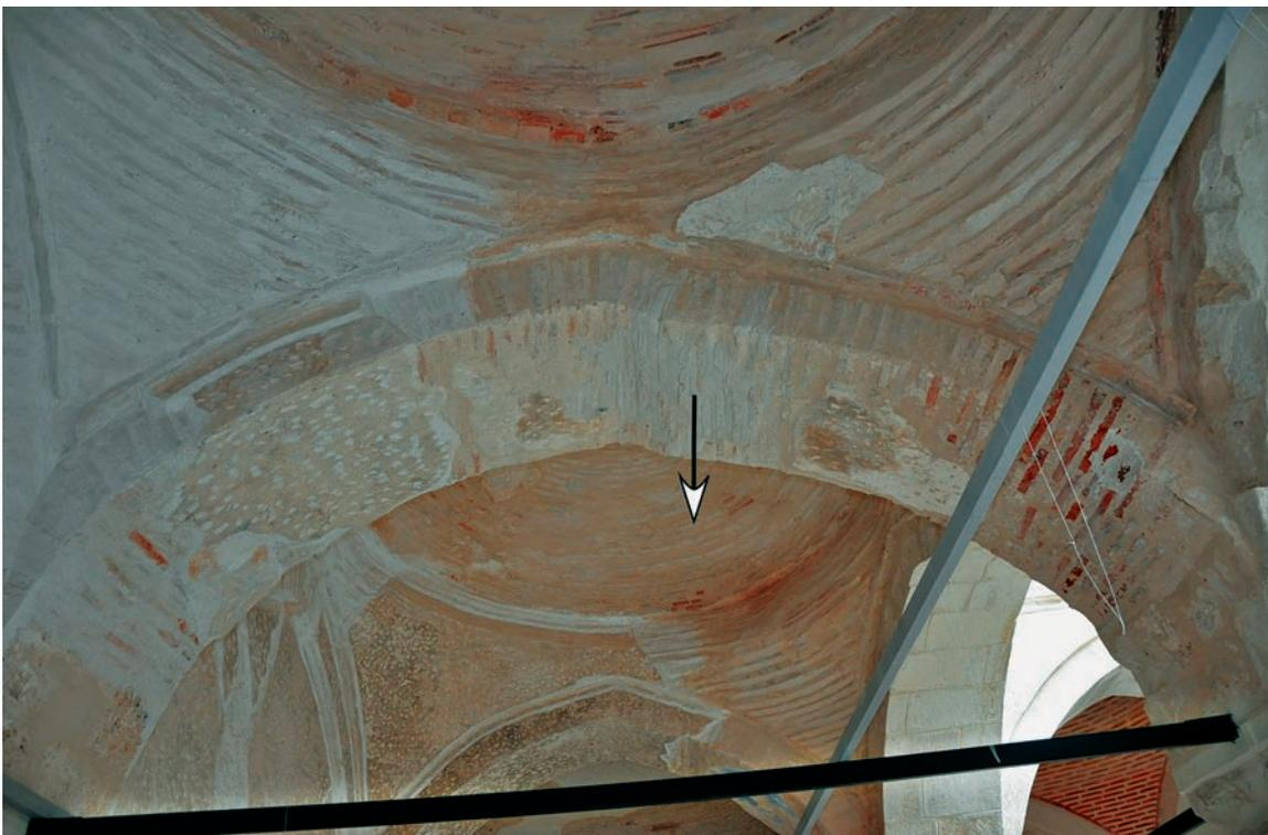
**Рис. 6.** Провисание части арочной конструкции субширотного простираия в Зынджирлы-медресе
