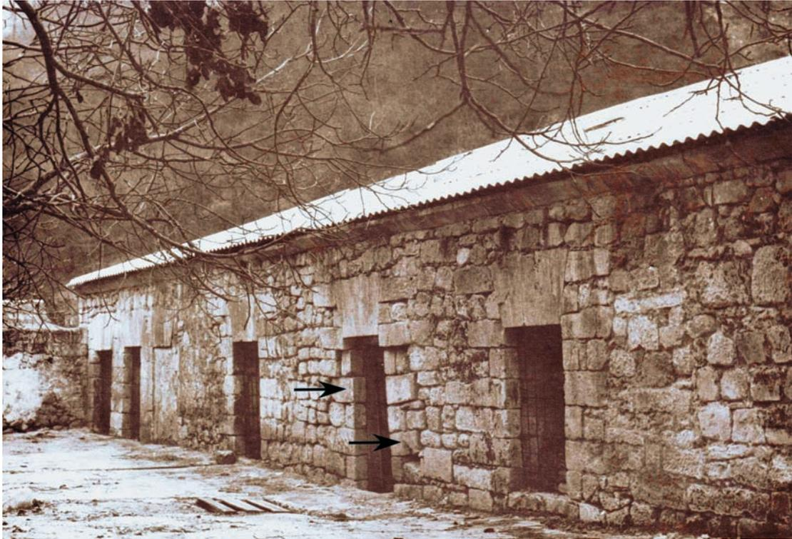
**Рис. 5.** Вдвинутая вовнутрь косяковая часть одного из дверных проемов в Зынджирлы-медресе (показана стрелками). Вид на ее западную стену с юго-востока. Фотография из Научного архива БИКАМЗ. Ф. 05. Оп. 7. Д. 288. Л. 372. Неизвестный фотограф. 1961 г.
