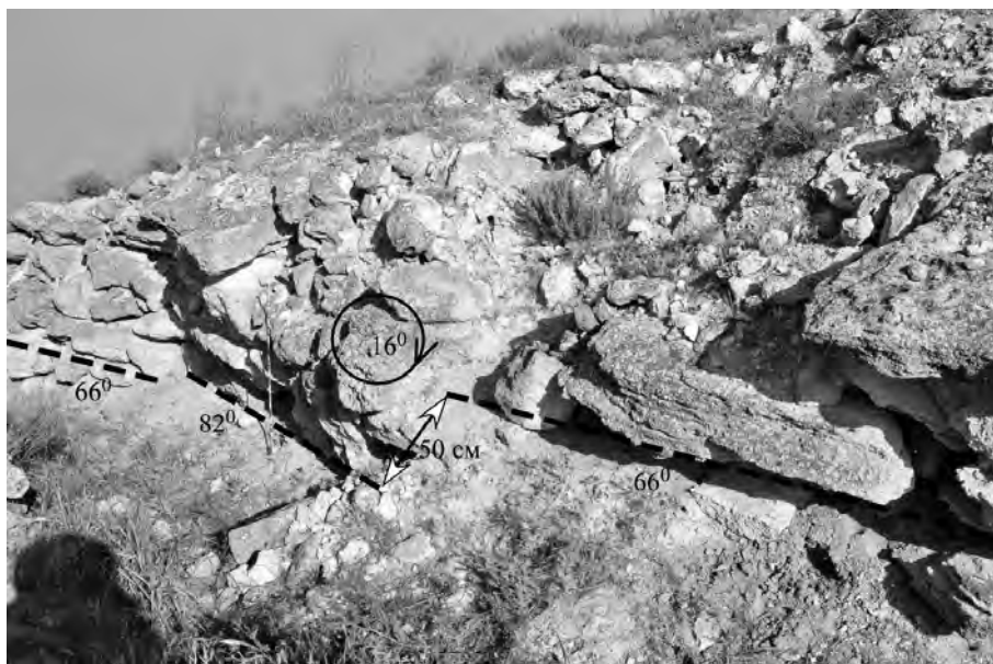
Рис. 4. Поворот по часовой стрелке средней части южной стены башни византийского времени
