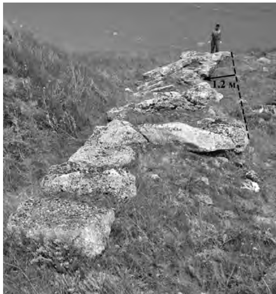
Рис. 11. Значительный изгиб на плане стены ЮВ простирания в СЗ направлении. Сильные сейсмические воздействия привели к максимальному изгибу стены в центральной части, где имела место максимальная свобода колебаний. «а» – план, «б» – фотография стены, вид на СЗ. Прерывистые линии – первоначальное положение фасов стены. Черные линии со стрелкой указывают направление смещения строительной конструкции
