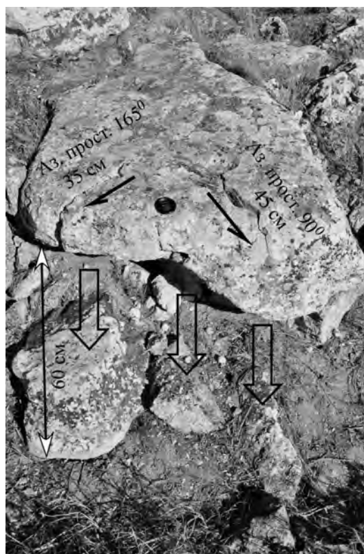
Рис. 9. Сопряженные сколы на камне 2 в стене № 2 (раскоп 1953 г.). Они образовались вследствие концентрации здесь сейсмических напряжений. Этот же процесс привел к тому, что нижерасположенный каменный блок выдвинулся к югу и раскрошился на несколько частей
