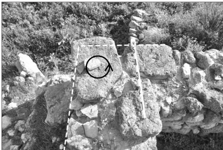
Рис. 8. Вращение против часовой стрелки на 15^\circ одного из каменных блоков в СЗ углу одного из строительных комплексов в точке наблюдения 61-2016.
