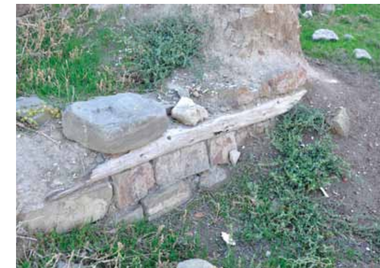
Рис. 20. Деревянные балки в нижних частях каменных кладок (фото 2015 г.): а) в разобранной стене к югу от башни Коррадо Чигала; б) в одной из стен католического храма Пресвятой Девы Марии – антисейсмический прием в средневековом строительстве
