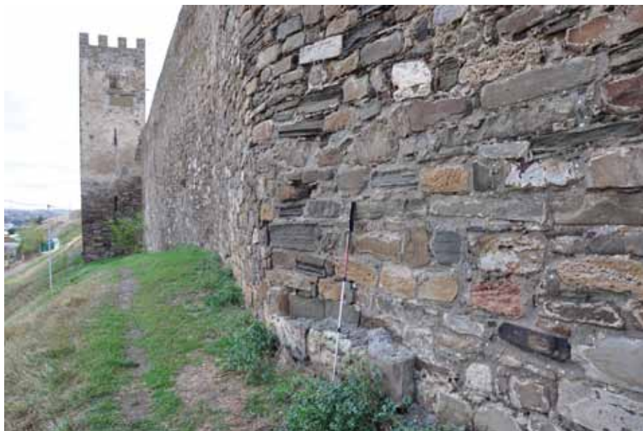
Рис. 9. Изломы в северном фазе крепостной стены, связанные с поворотом ее восточной части по часовой стрелке на 15^\circ :
