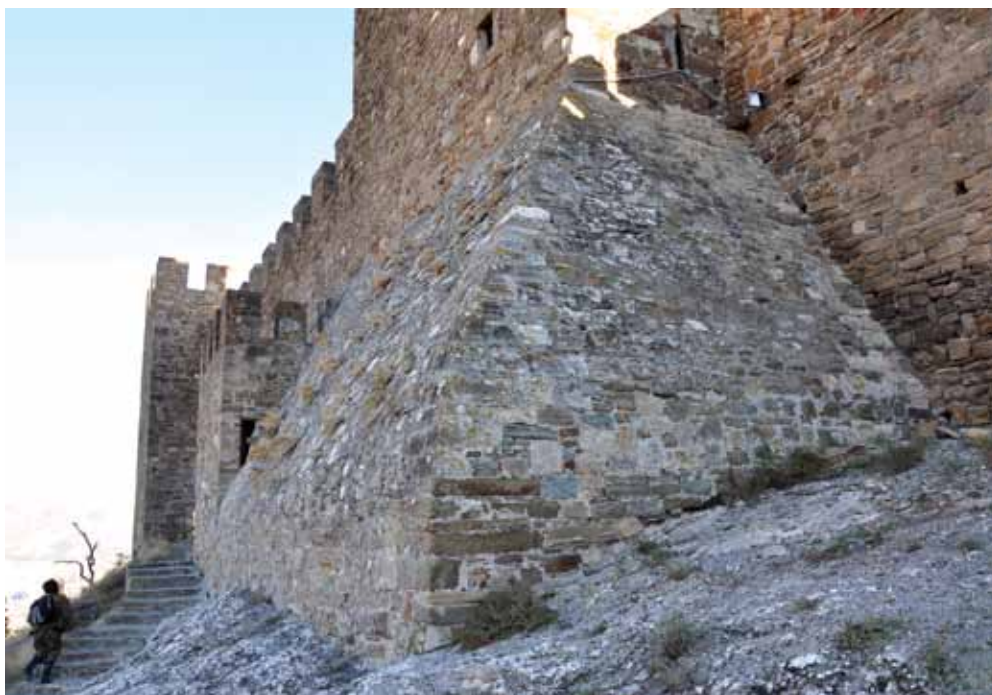
Рис. 18. Стена-крепиды (контрфорс) в углу между Консульским замком и крепостной стеной к западу. Вид на восток. Фото 2015 г.
