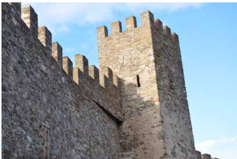
Рис. 7. Разворот по часовой стрелке значительного фрагмента крепостной стены Судакской крепости в ее верхней части к востоку от башни Коррадо Чигала
