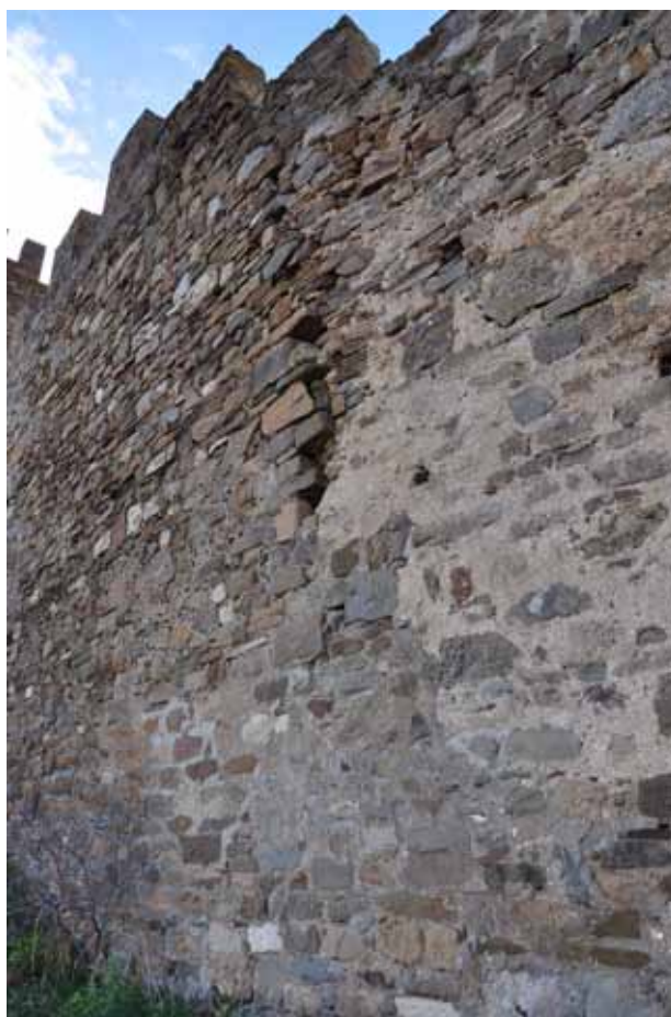
Рис. 8. Небольшой разворот по часовой стрелке в средней части северной крепостной стены Судакской крепости между башнями Коррадо Чигала и Лукини ди Фиески ди Лаванья
