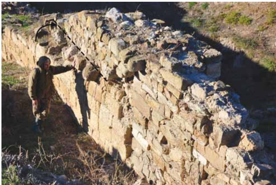
Рис. 10. Вращение по часовой стрелке фрагмента северной крепостной стены Судакской крепости к западу от Безымянной башни № 10:
