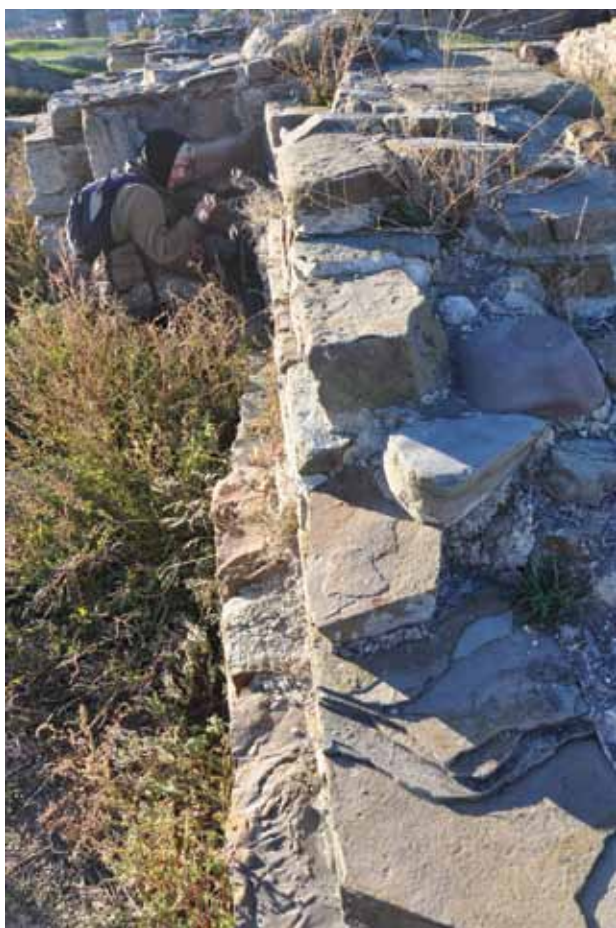
Рис. 6. Смещение к югу нижней части южной стены храма Пресвятой Девы Марии. В связи с этим перемещением в южном фазе стены образовалась полочка шириной до 30 см
