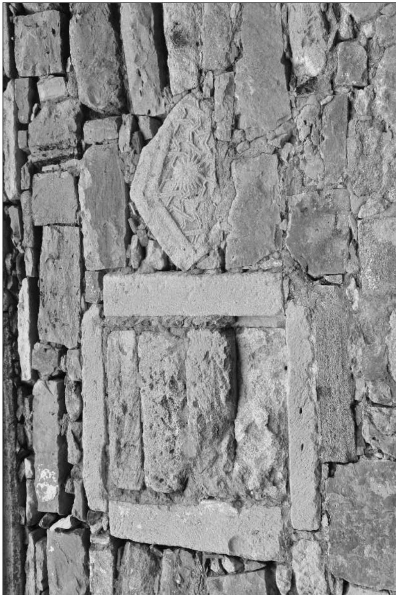
Рис. 3. Южная стена церкви. Заложенное окно I-го строительного периода в западной части южной стены церкви, а также вторичное использование в кладке фрагмента архитектурной детали с розеткой. Вид на север.
