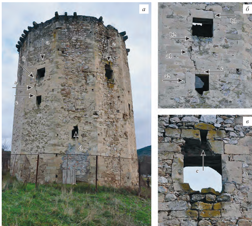
Рис. 11. Чоргуньская башня, общий вид граней с простираем 180°, 210° и 240° (а) и фрагменты граней с простираем 240° (б) и 180° (в): а – межблочная трещина; б – трещины в плите перекрытия и в подоконнике окна в грани с простираем 240° третьего этажа; с – трещина в плите перекрытия окна в грани с простираем 240° второго этажа; d – разбитая на три части (одна утрачена) плита перекрытия окна в грани с простираем 210°; e – разбитая на три части (две утрачены) плита перекрытия окна в грани с простираем 180°
