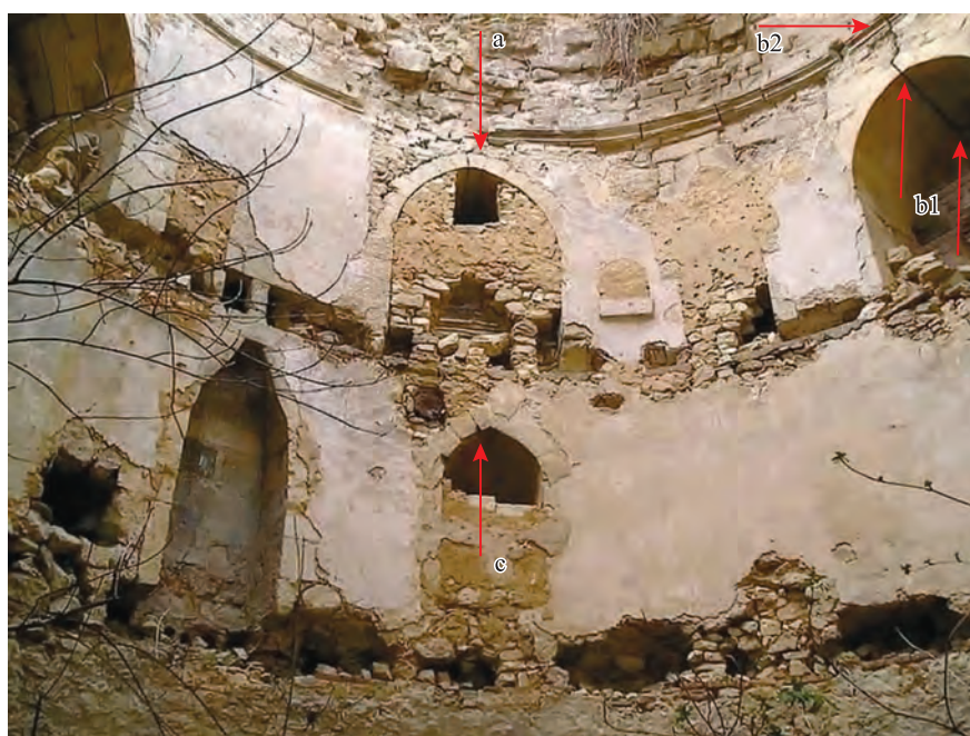
Рис. 11. Чоргуньская башня, общий вид граней с простираем 180°, 210° и 240° (а) и фрагменты граней с простираем 240° (б) и 180° (в): а – межблочная трещина; б – трещины в плите перекрытия и в подоконнике окна в грани с простираем 240° третьего этажа; с – трещина в плите перекрытия окна в грани с простираем 240° второго этажа; d – разбитая на три части (одна утрачена) плита перекрытия окна в грани с простираем 210°; e – разбитая на три части (две утрачены) плита перекрытия окна в грани с простираем 180°
