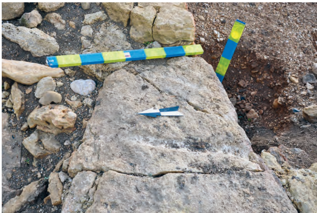
Рис. 5. Античная усадьба хоры Херсонеса Таврического на высоте Масляная. Помещение VI. Оборонительная стена усадьбы. Сквозная трещина растяжения, пробивающая два блока подряд в наружной стене усадьбы. Вид сверху
