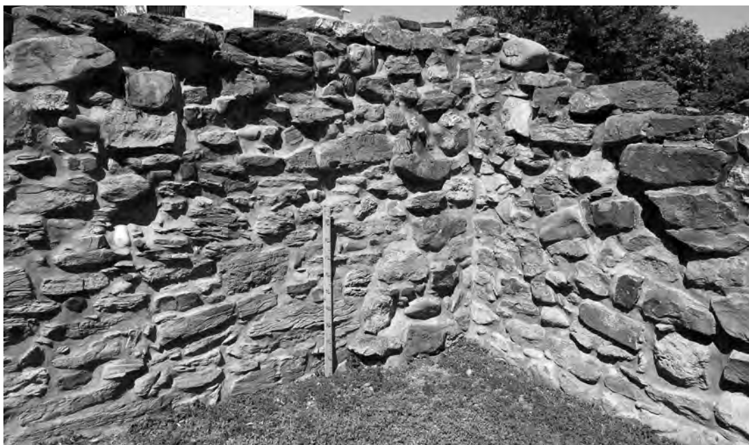
Рис. 12. Следы перекладки стен в северо-восточном углу помещения 22 дома 11 IV строительного периода
