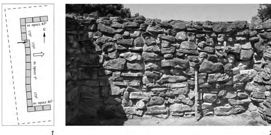
Рис. 8. Т.н. 3-19: изгибная в плане деформация западной стены помещения 116 (направление показано белой стрелкой), приведшая к ее разрыву (черная стрелка). 1 – схематическая зарисовка, вид в плане; 2 – фото, вид с востока
