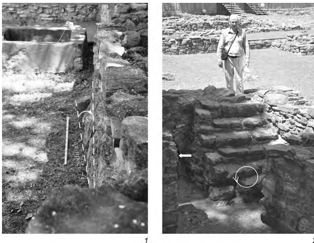
Рис. 11. 1 – т.н. 5–19: разворот верхней части субширотной стены относительно нижнего ряда каменной кладки по часовой стрелке. Вид с запада; 2 – т.н. 10–19: расседание каменной лестницы, приведшее к выдвиганию камней ее южного ограничения на юг (показано белой стрелкой). Наблюдается последовательный разворот каменных ступеней против часовой стрелки с увеличением угла поворота вниз по лестнице
