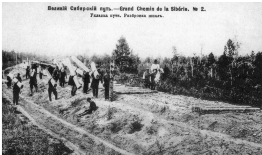
Рис. 1. Строительство Транссибирской магистрали: разброска шпал ( www.islamnews.ru ).
