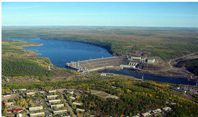
Рис. 15. Вилюйская ГЭС – первая в мире каменнонабросная плотина на вечной мерзлоте (images.yandex.ru).
